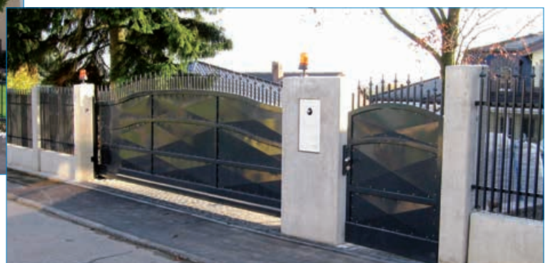
▲ Zaunanlage mit Zierspitzen und Blechfüllung
