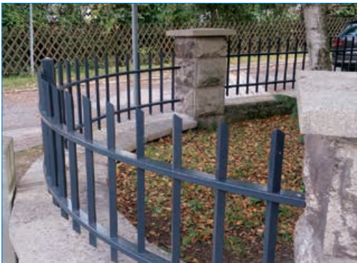
▼ Felderzaun FQÜ im Bogen gefertigt
